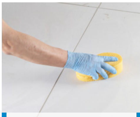
Rengjøring og sluttbehandling av fugene med hard cellulose svamp (spongo)
