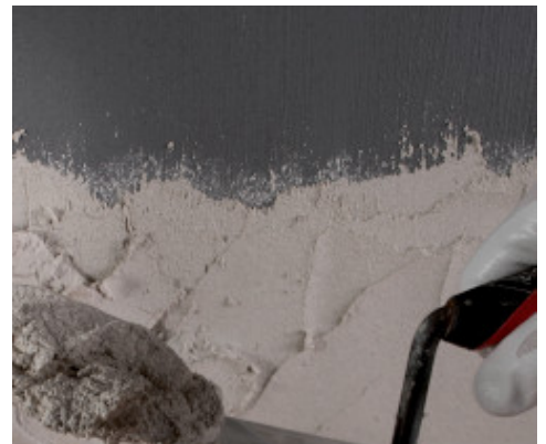
Påføring av puss over Eco Prim Grip Plus
