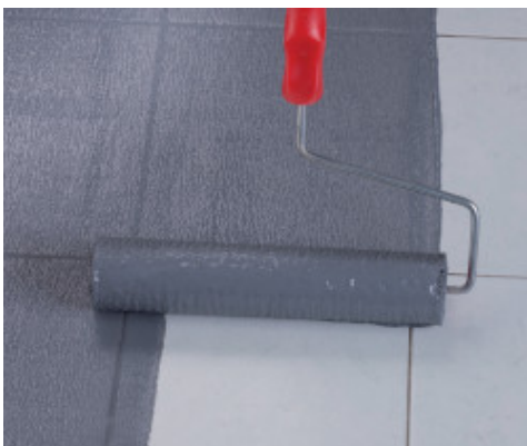
Påføring av Eco Prim Grip Plus med rulle på eksisterende porselensfliser
