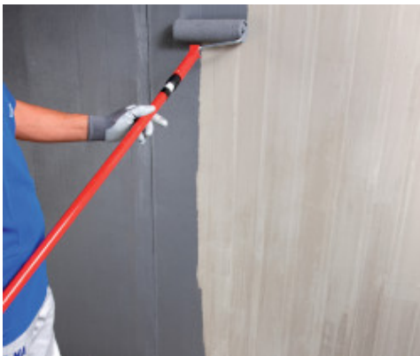
Påføring av Eco Prim Grip Plus på betong med rulle
